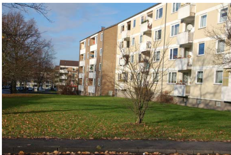
Abbildung 5: Wohngebäude und Freiflächen
