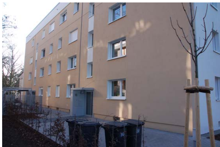
Abbildung 8: Vorderseite der Gebäude nach Modernisierung/Aufstockung
