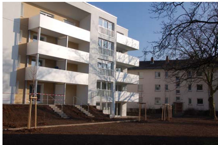
Abbildung 9: Rückseite der modernisierten Häuser und alter Zustand (rechts)
