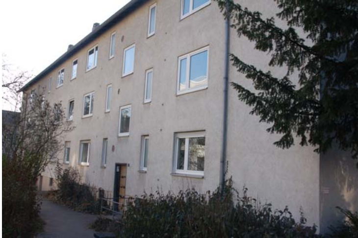
Abbildung 7: Vorderseite der Gebäude vor der Modernisierung
